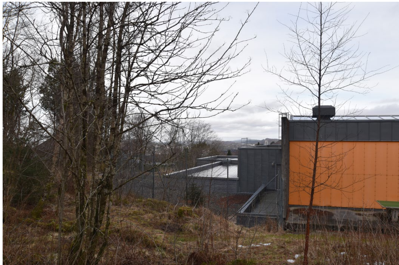
Dagens situasjon med gjerde og takflate man ikke kan bruke.
